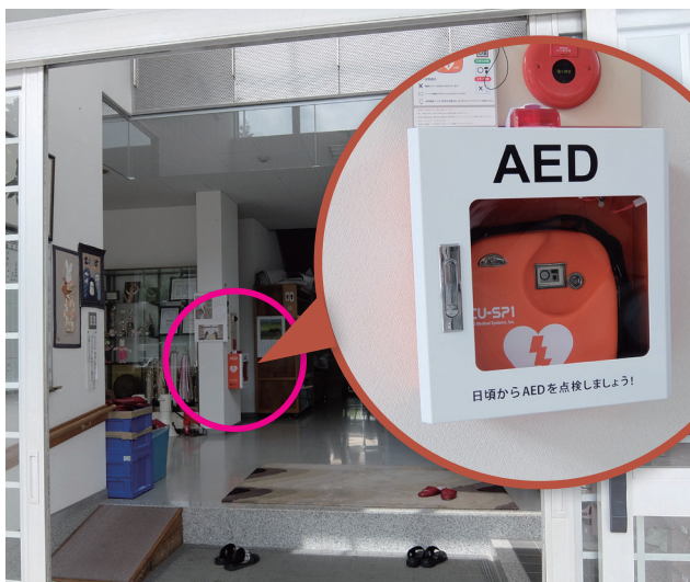
A E D（自動体外式除細動器）を設置しました
